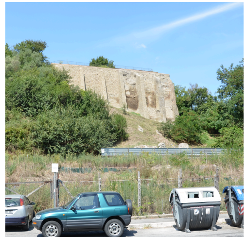
別荘擁壁の現況*
