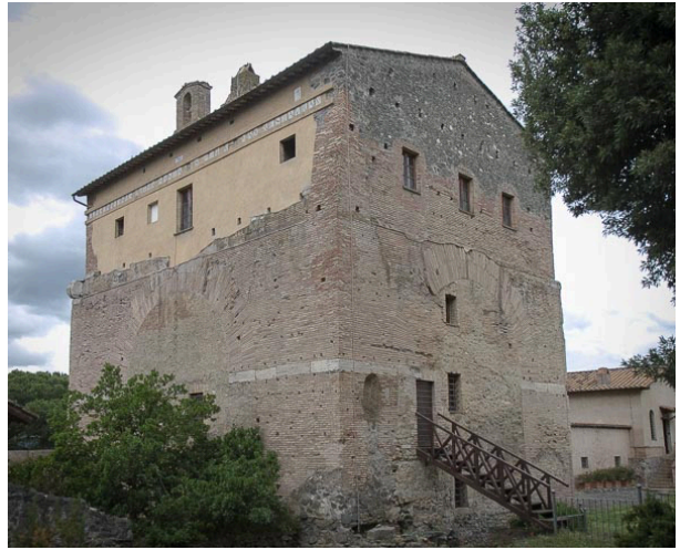
四面門現況（南東から見る）
