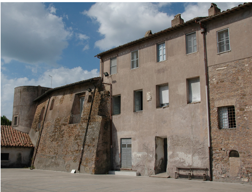
Fig. 17 市壁のカウンタスケープと共にみる 司教館東側ファサード The east façade of the Episcopio with the counterscape of the city wall
