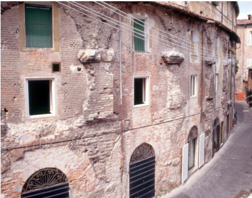
Fig. 2 円形闘技場街区：ローマ期のアー ケードを取り込んだ街区壁面 (via dell'Anfiteatro 側) Amphitheatre block: elevation with the reused roman arcade (via dell' Anfiteatro)
