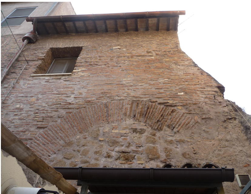
Fig. 25 水道橋第3アーチの詳細 The detail of the third arch
