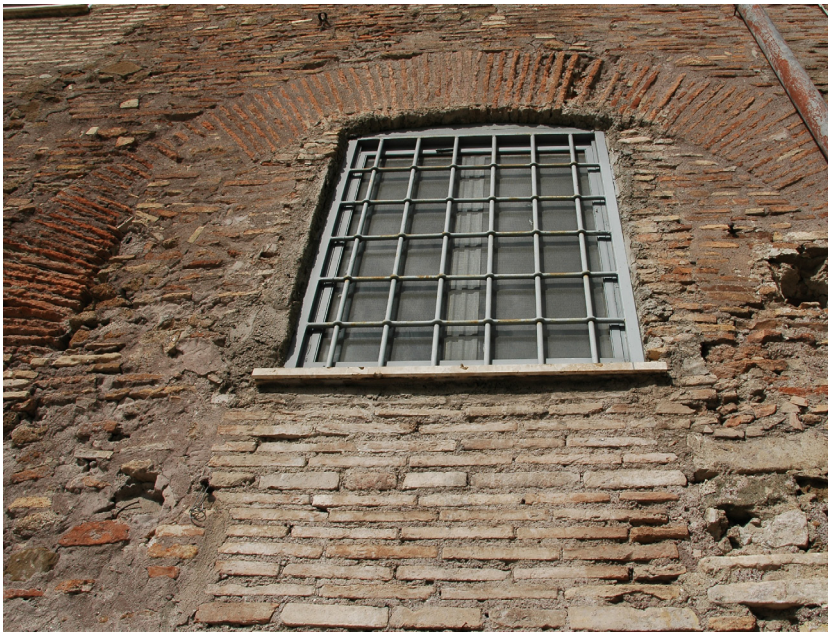
Fig. 24 水道橋第2アーチの詳細 The detail of the second arch
