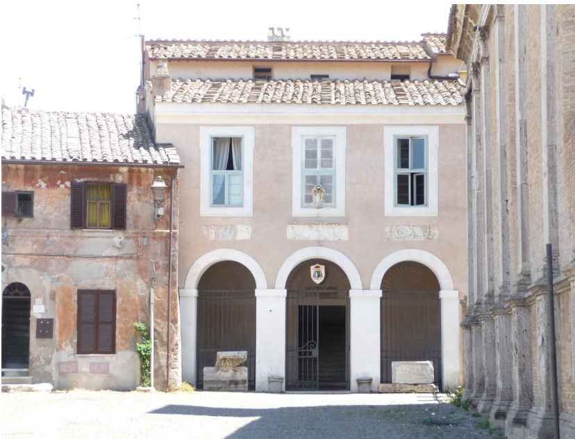
Fig. 16 司教館正面入口のポルティコ The portico of the Episcopio
