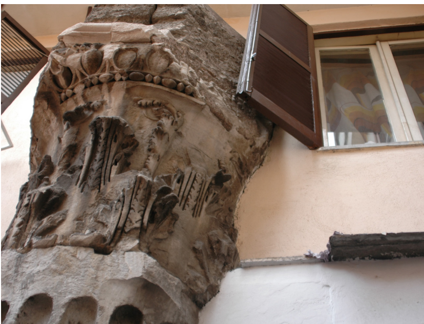
Fig. 7 住宅の中庭に表出する古代神殿の円 柱 A column of an ancient temple surfacing in the residential court
