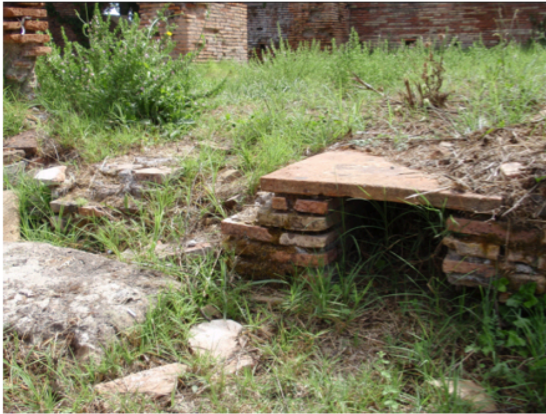
図2-1 オスティアのススペンスーラ（倉庫の高床）（Grandi Horrea = II, IX, 7）
