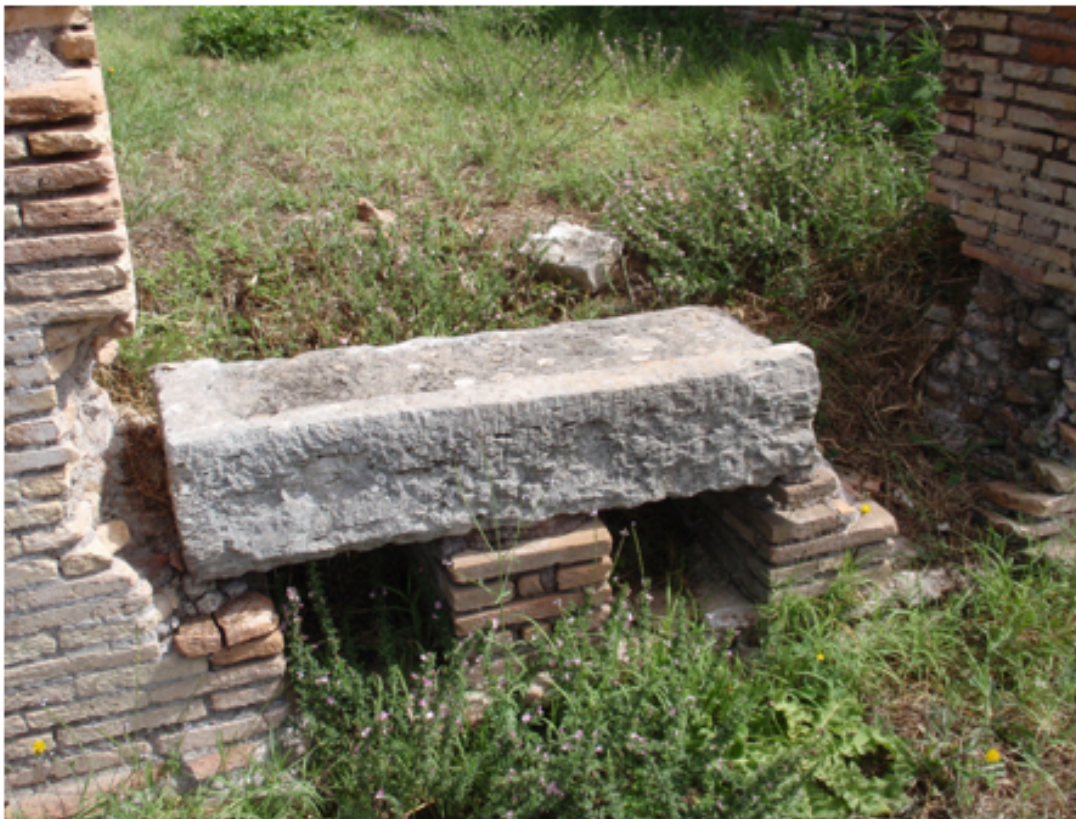
図2-2 オスティアのススペンスーラ（倉庫の高床）（Grandi Horrea = II, IX, 7）
