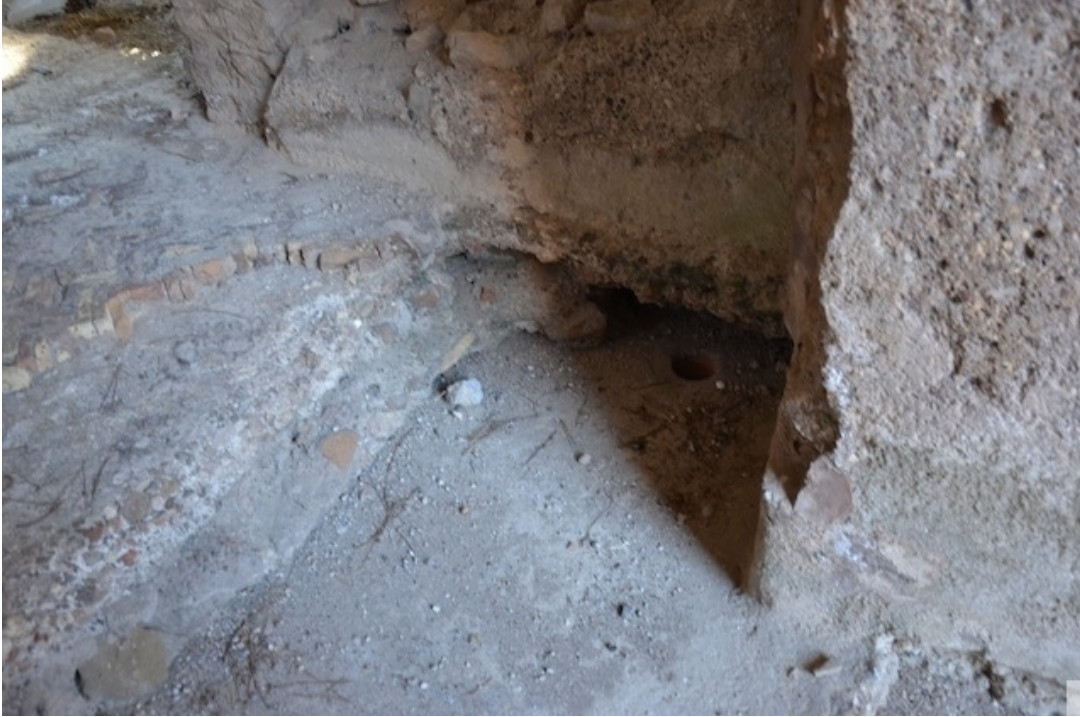
写真13-2 部屋5の東南隅の状況：右隅の穴は補修時の水抜きか
