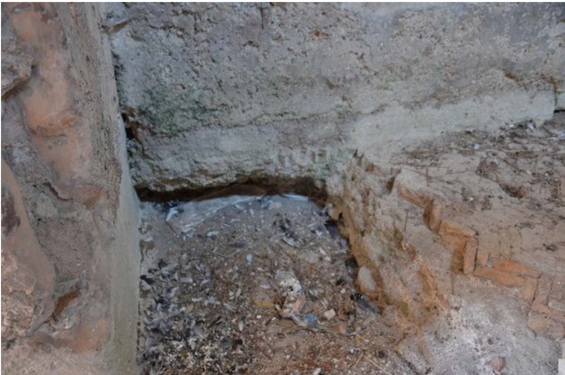
写真13-1 部屋5の南西隅の状況
