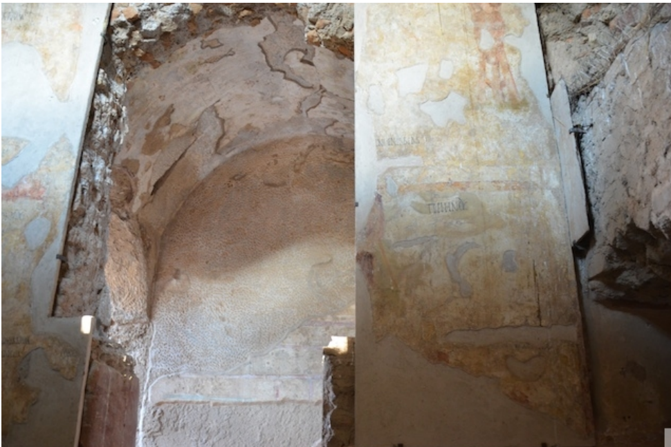
写真17-2 水浴槽4への出入口と、西壁右
