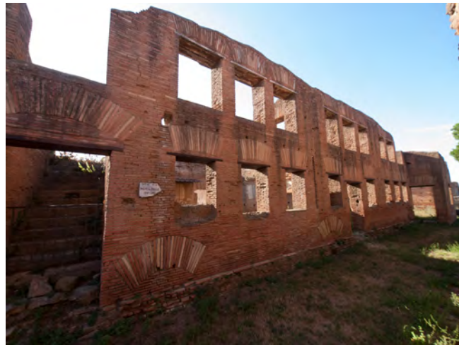
図30, 「カッセジャート・デッレ・トリフォーレ」と呼ばれる店舗兼住宅
