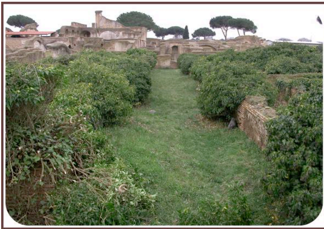
Ostia Antica. Complesso abitativo prima e dopo il diserbo
